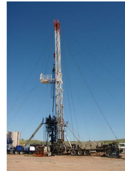
Plataforma de reparacion
