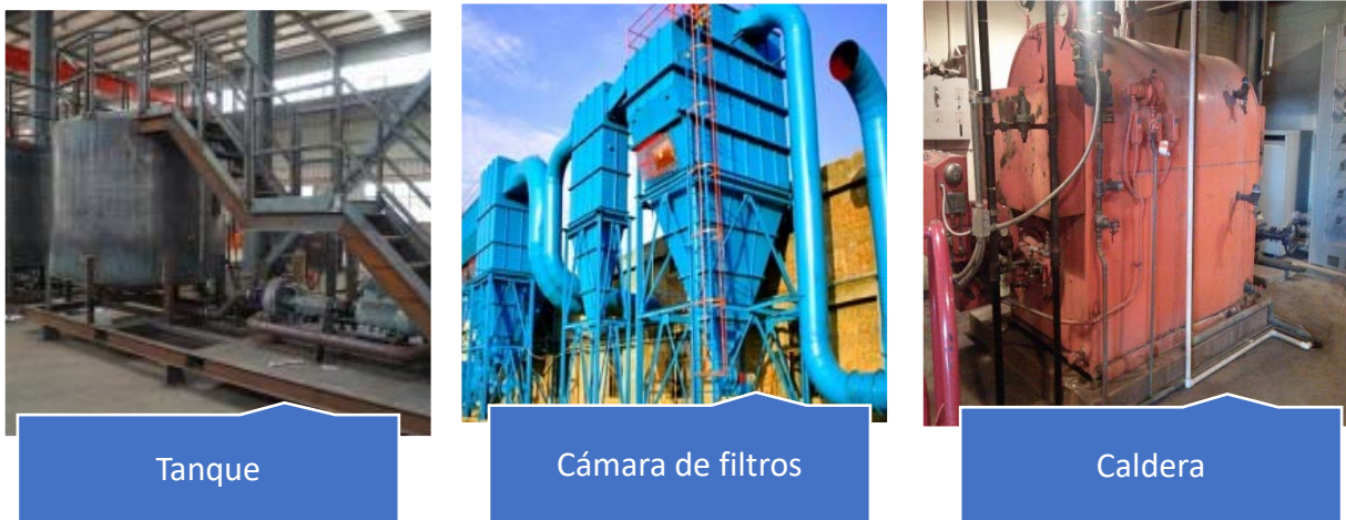
Figura 4-7: Ejemplos de Equipo de Instalaciones Generales Industriales
