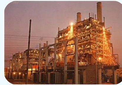
Instalaciones generadoras de electricidad
