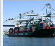
Fuentes de energía eléctrica en puerto
