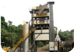
Plantas de asfalto
